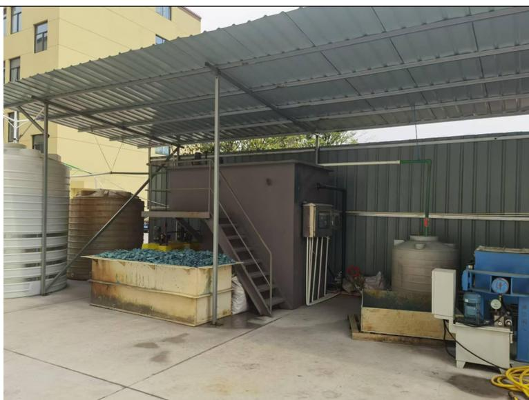
生产废水处理设施（隔油调节池+混凝沉淀）
