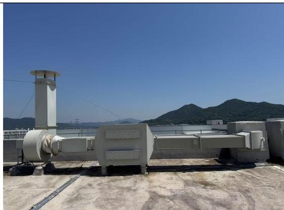
无机废气处理设施及排气筒
